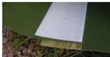
**Etape n° 2:** Plier les joints superposés (et collés) en Z, comme indiqué, et coller une 3<sup>e</sup> bande sur la face arrière, sans enlever le papier de protection.
