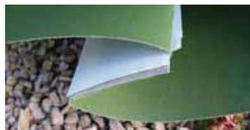
**Etape n° 3:** Quand les joints sont bien aplatis et plats, enlever les papiers de protections restants et presser fortement les joints ensemble. Plus aucune racine ne pourra passer à travers le tube ainsi refermé.
